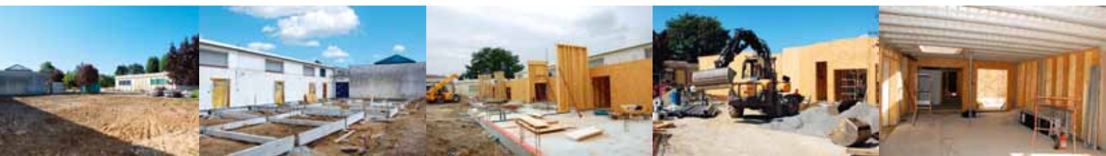
Un point sur les travaux à l'école maternelle
