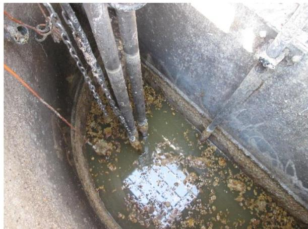
*Intérieur du poste de refoulement constitué de 2 cuvons séparés*
