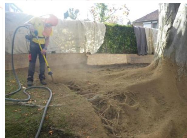
**Figure 6 :** Décompaction avec le système Air Spade, source : vos-arbres.be
