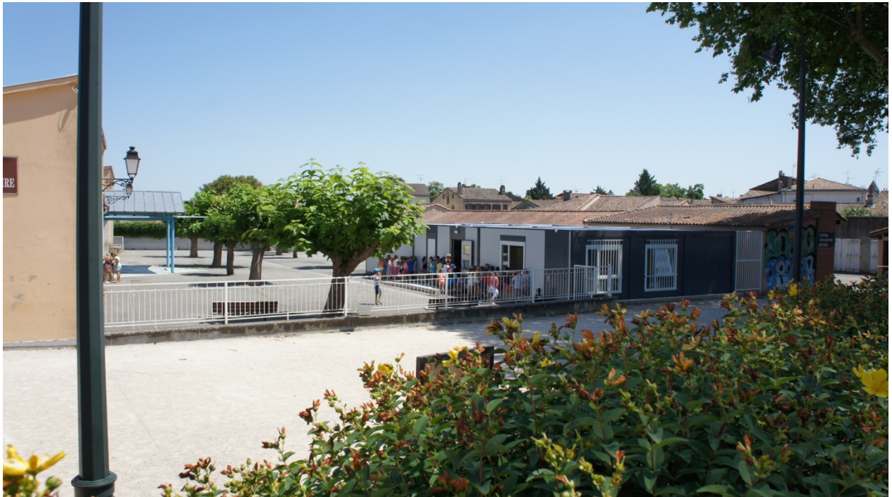
Bâtiments préfabriqués provisoires et cour de l'école élémentaire
